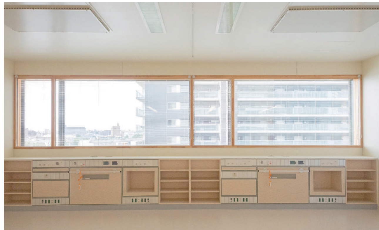
埼玉県立小児医療センター 子どもの集中治療室の窓に対する結露対策として採用されました。FIXタイプでブラインドを配備しています。
