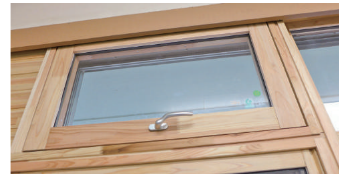
板橋区立 板橋第二小学校 配管部分をFIXパネルとしました。内倒しタイプの窓も取り付けています。 それ以外の部分には欄間を設けずに一枚の大きなサッシ W930×H1780mm で作成しました。
