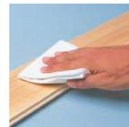
**4** 約10~20分後に、吸収されなかった余分なオイルを毛羽立ちのない布で拭き取ります。その後約12時間乾燥させて下さい。(気候湿度・日照等により乾燥時間が若干異なります。)
