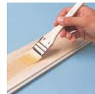
**3** 刷毛、布、吹き付けのいずれかが木目に沿い出来るだけ薄く均一に塗布して下さい。
